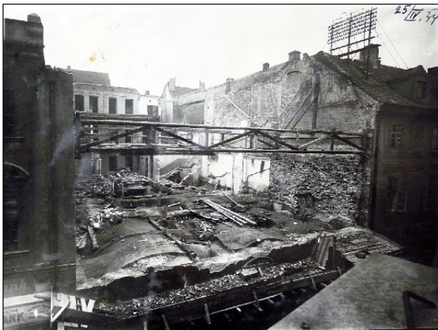
Pohled ze Štupartské ulice na bourání domu, foceno 25.4.1934
