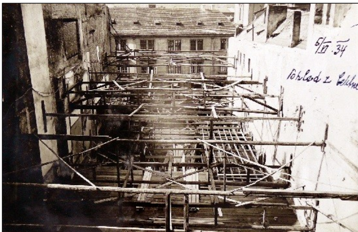
Pohled z Celetné ulice na bourání domu, foceno 5.6.1934 (SOKA Zlín)
